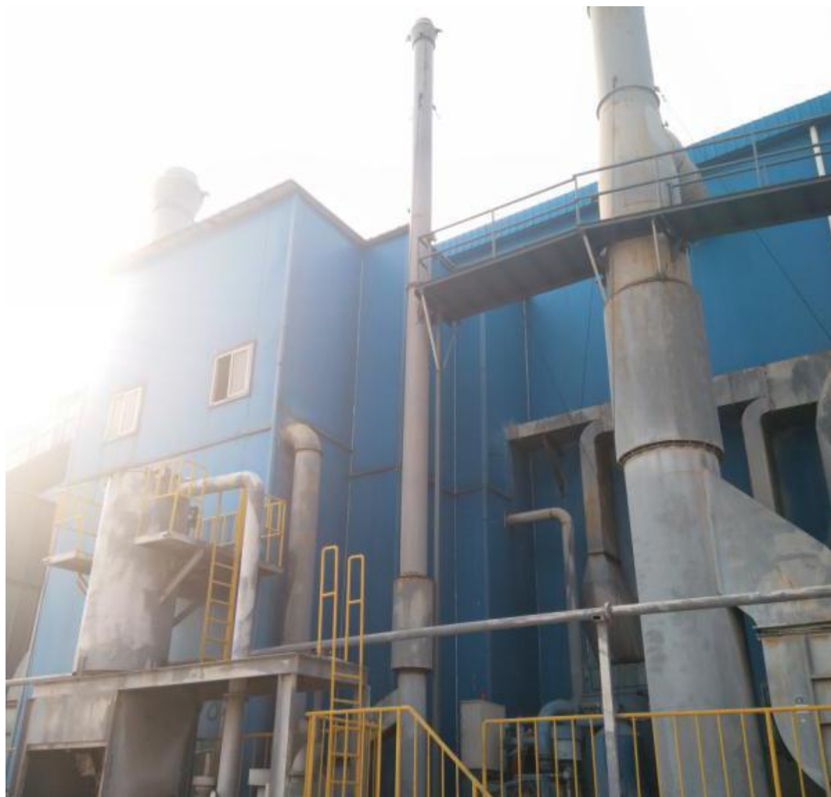
图3-4 提升机排气筒
