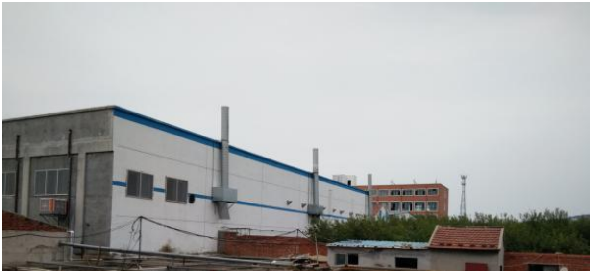
图 3-2 烘干炉排气筒
