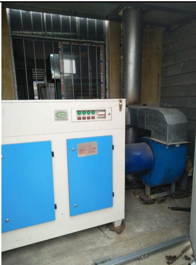
图 4-2 废气净化装置+排气筒
