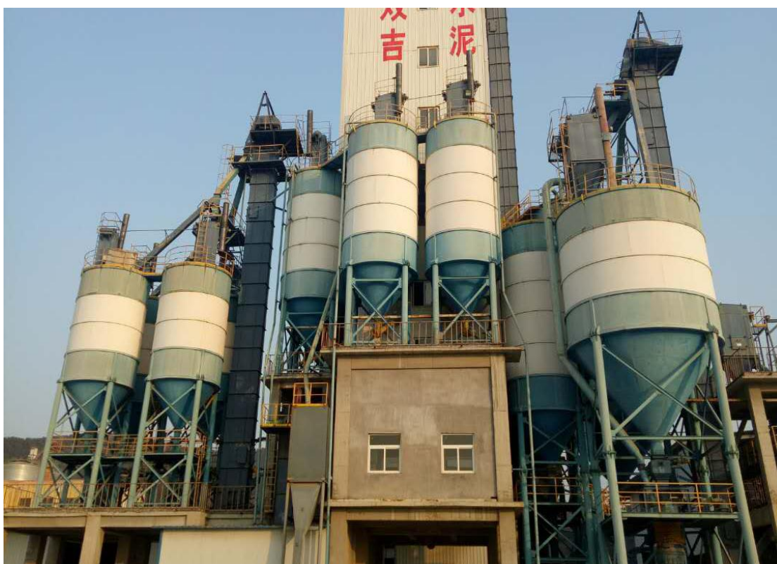
图 4-1 部分除尘器及排气筒照片
